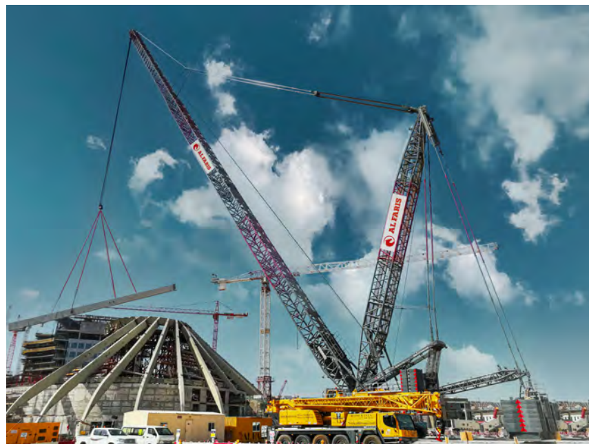
Al Faris montiert mit dem Liebherr-Raupenkran LR 11000 42 Stahlelemente für die EXPO 2021.
